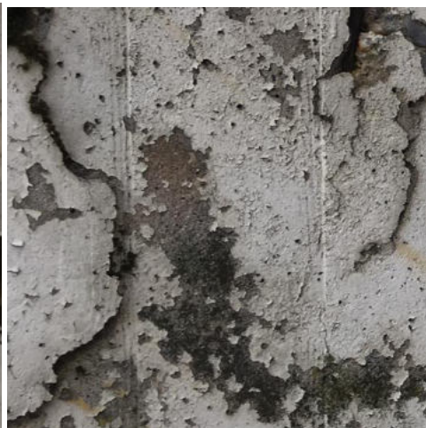
Sinterbildung unter Beschichtung
