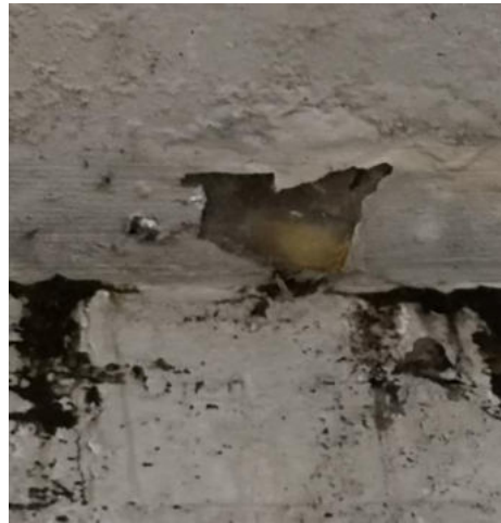
Sinterbildung unter Beschichtung
