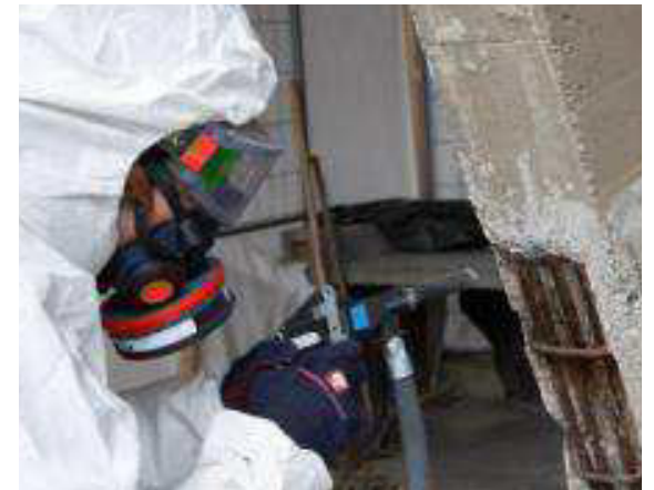
Rostentfernung bei Bewehrungen
