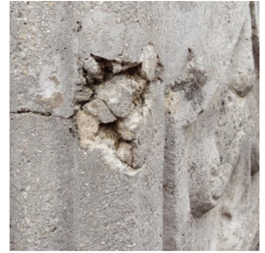
Würfelbruch (Winddruck)
