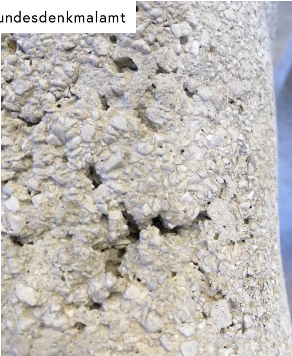
Haarrissysteme und kleine Lunker (wo darüber die Gußhaut verloren ging) zahlreiche mechanische Schäden
