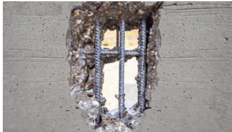
Vorschneiden (bei Verwendung von Instandsetzungs- mörtel mindestens 5 mm, an- sonsten mindestens 10 mm)
