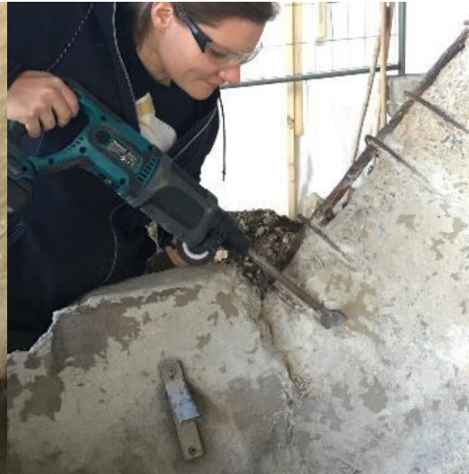
Vorschneiden (bei Verwendung von Instandsetzungs- mörtel mindestens 5 mm, an- sonsten mindestens 10 mm)
